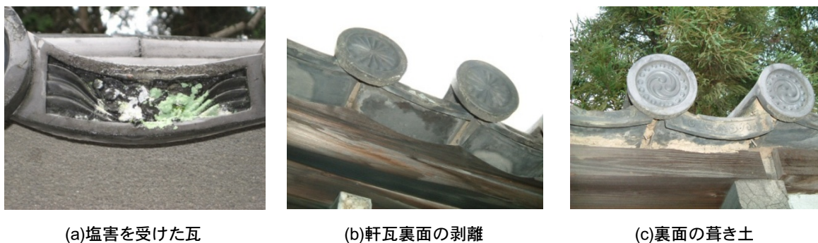
写真 2.3.7 その他部位、他種の瓦の劣化
