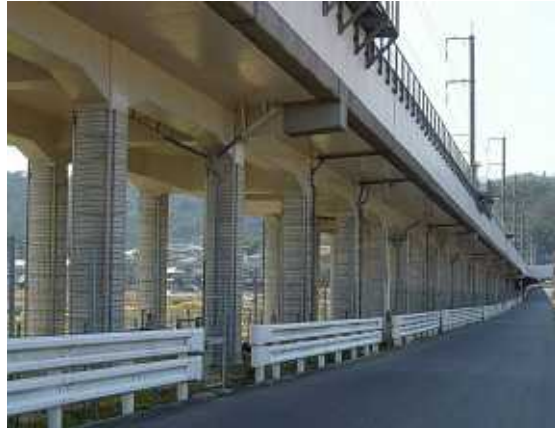
写真-6.1 本工法による耐震補強の施工
