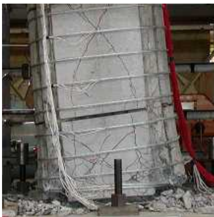
写真-3.1 セグメント端部の破壊 (AP-3)
