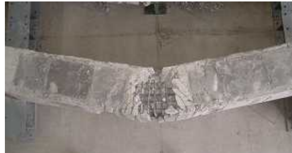
(e) 側面 セグメント撤去後(ボンド試験体)
