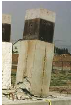
c-4) 鋼板切断撤去後
