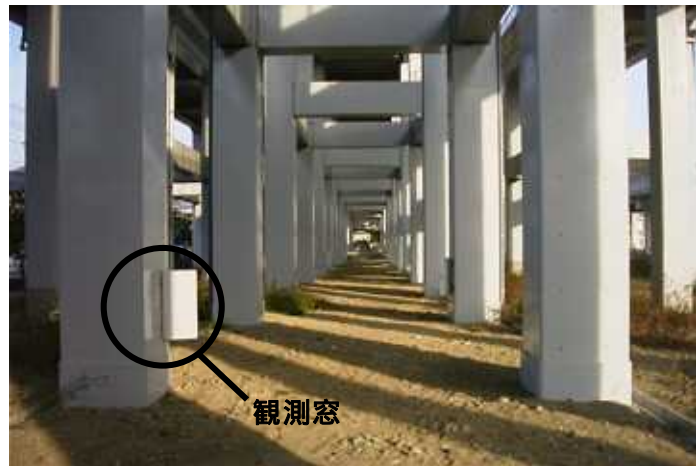
写真-1.2 鋼板巻立て補強工法により補強した柱に設置した維持管理のための観測窓
