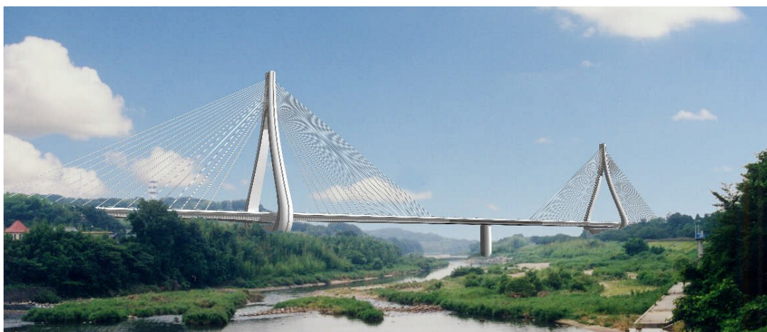
写真 1.1.14 矢作川橋（波形鋼板ウェブ斜張橋）
