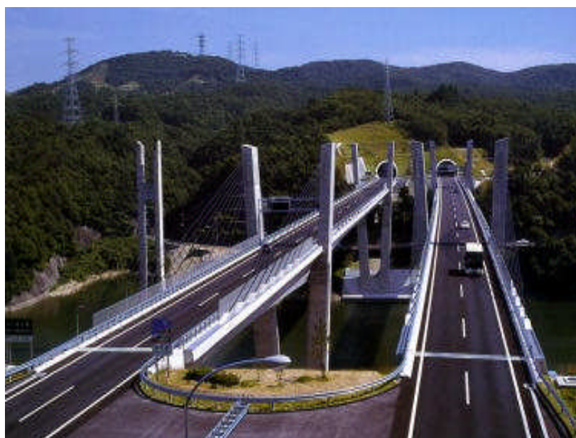
写真 1.1.5 つくはら橋(PCエクストラドーズド橋)
