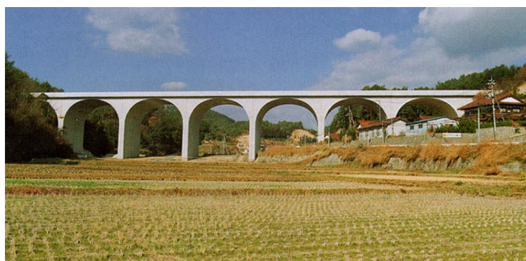
写真 1.1.1 栴坂高架橋（RC 充複アーチ）
