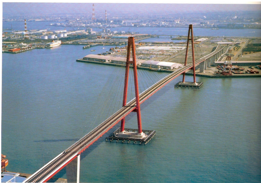
写真 1.1.9 名港西大橋（1期線）
