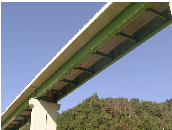
写真 1.1.10 大津呂川橋（鋼少数主桁橋）
