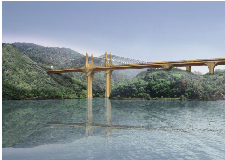
写真 1.1.13 栗東橋（波形鋼板ウェブエクストラードースト橋）
