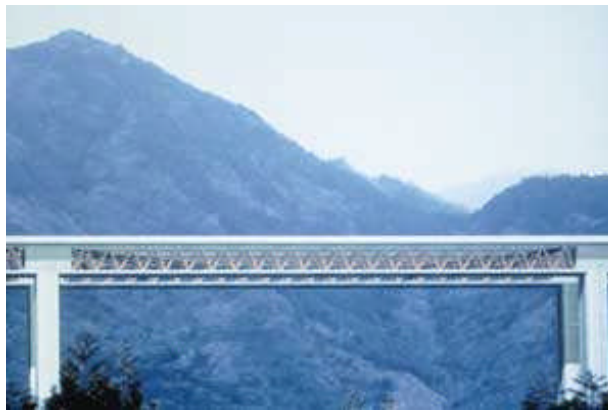
写真 1.1.15 猿田川橋（鋼トラスウェブ複合橋）
