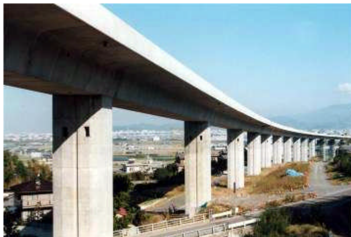
写真 1.1.7 重信川橋（プレキャストセグメント）
