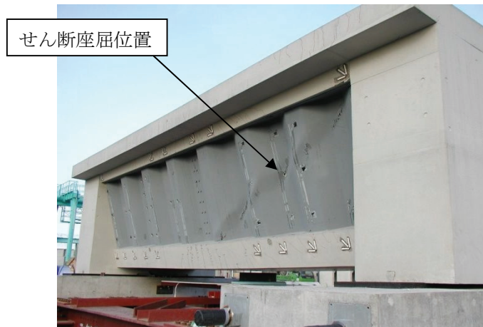
写真-2.2.2 せん断座屈状況
