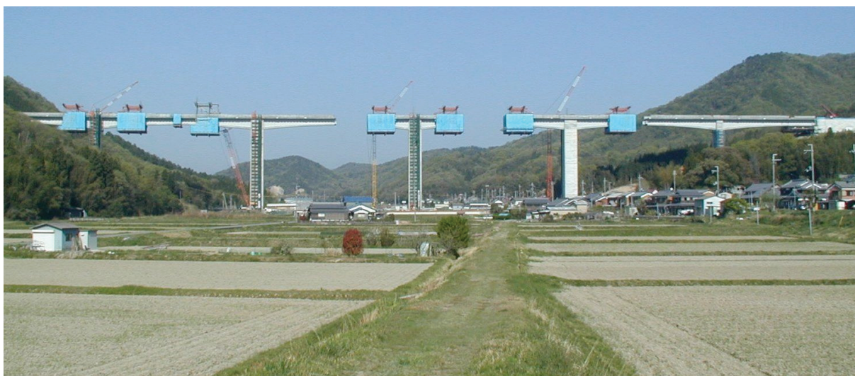
写真-2.1.5 波形鋼板ウェブ橋の片持ち張出し架設（小犬丸川橋）
