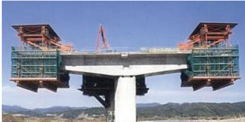
写真-1.2 片持ち張出し架設工法による PC 箱桁橋の施工例
