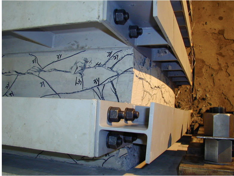
写真-3.2 5 \delta y_0 での橋脚基部の損傷状況
