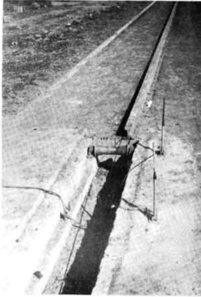
写真一 2 3 ガイドレール端末と第1ス リープ、コンクリート溝の 一部、速度計測装置
