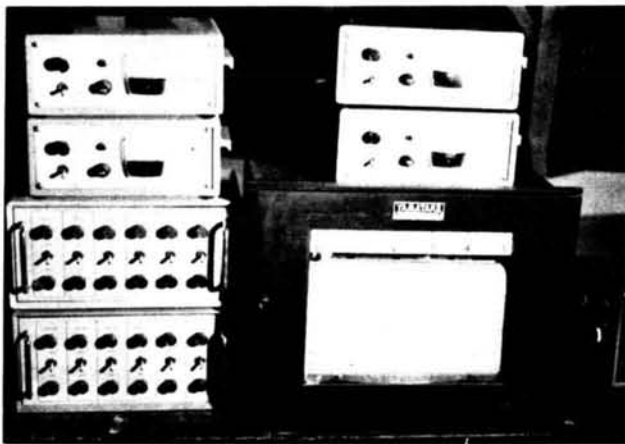
写真 1.2.5 電源箱，制御箱，記録計
