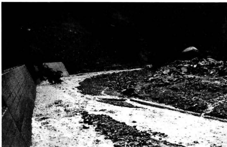
写真 4-4 観測水路付近の流れの状態(土石流通過の約3時間後)
