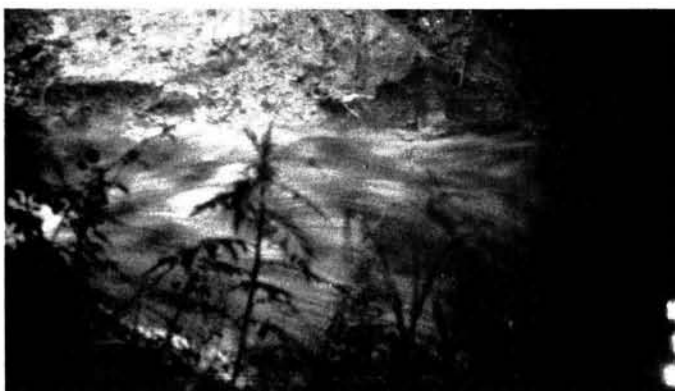
写真5-1 深谷砂防ダムを流下する土石流 (7時15分, 図5-6のA地点)
