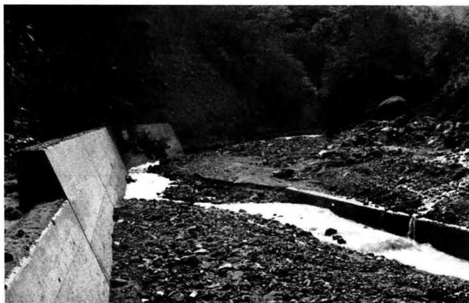
写真 4-5 観測水路付近の流れの状態(土石流通過の約10時間後)
