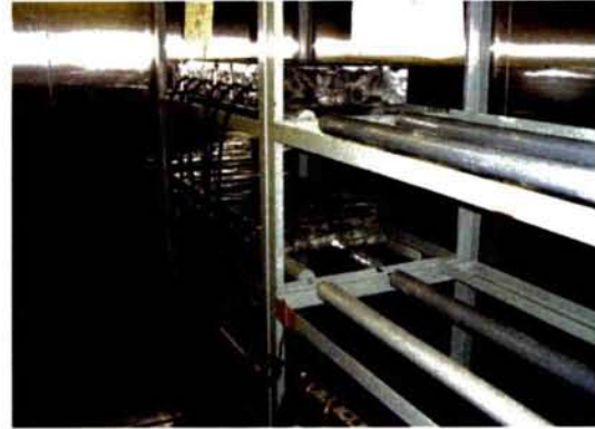
写真-5.2.5 養生状況
