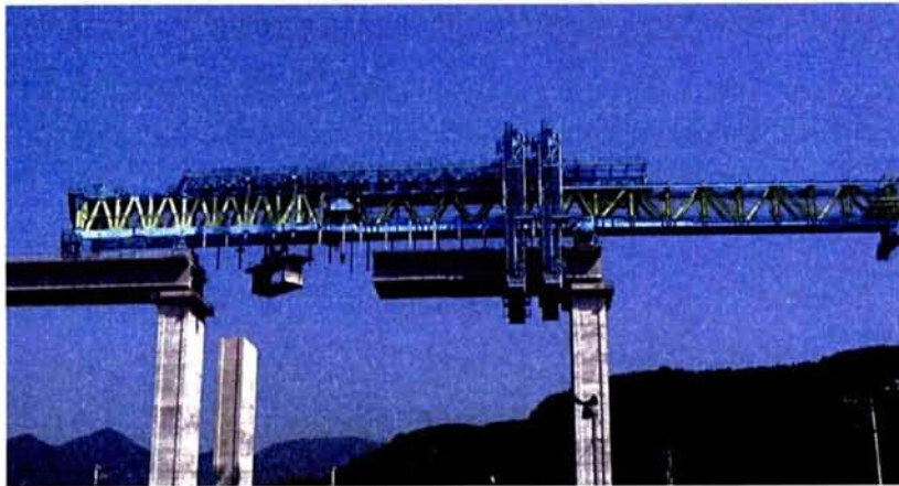
写真-2.1.1 スパンバイスパン工法によるプレキャストセグメントの架設
