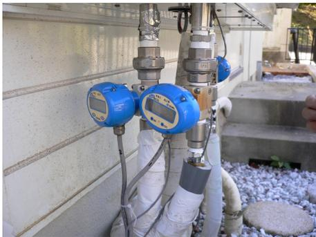
図 3.4 流量計取り付け状況
