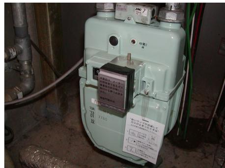
図 2.3 ガス流量計を取付けた状態
