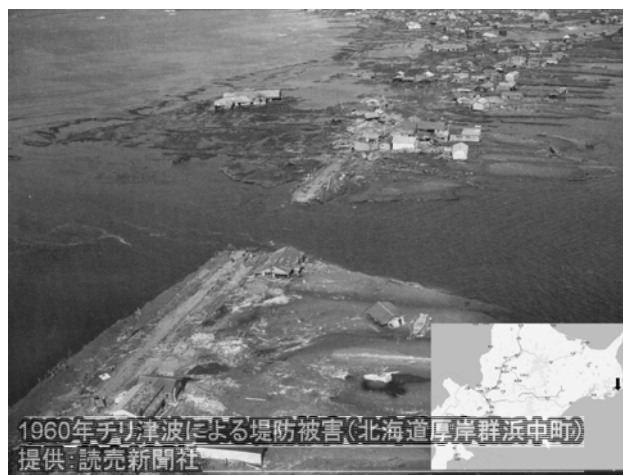
図 6.1-2 1960 年チリ津波による盛土堤防の被害：北海道厚岸郡浜中町
