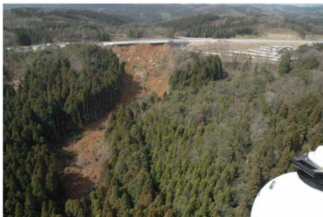
図 5.3.1-1 被災状況写真 1（国土交通省国土技術政策総合研究所、2008）
