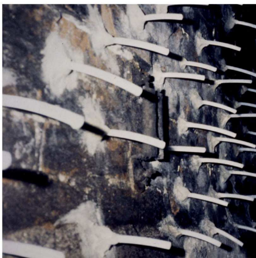
注入パイプ，目地部シール状況
