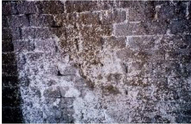
写真 2.3.1 二水石膏の生成による目地表層部の脆弱劣化
