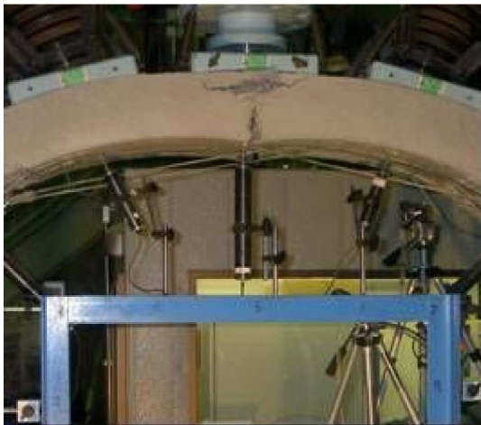
写真 4.3.1 ケース 4 の CFP 剥離状況
