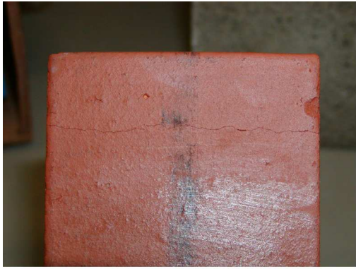
写真 5.4.1 凍結融解 420 サイクル時点の れんが表面の劣化状況
