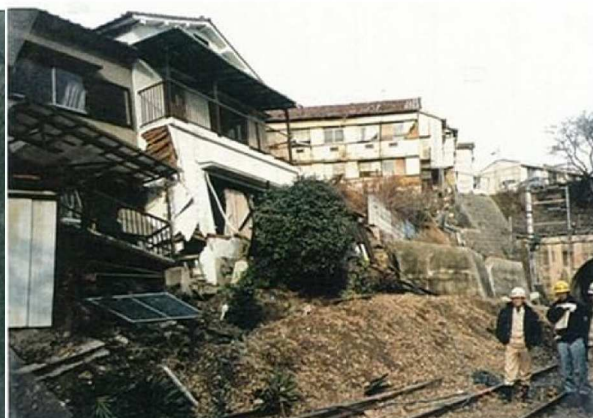
(b) 坑口付近の家屋の被害状況
