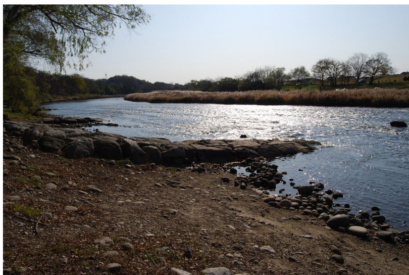
Fig. 1.7 古鼠水辺公園の石積み水制 (撮影日：2010年12月6日)
