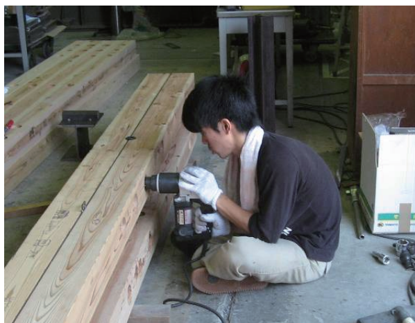
写真 4.3: ボルト締付
