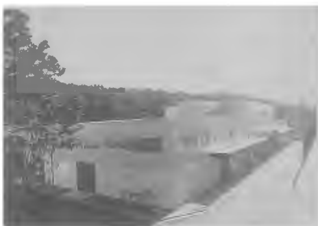
写真9-1 機械系教室実験研究棟
