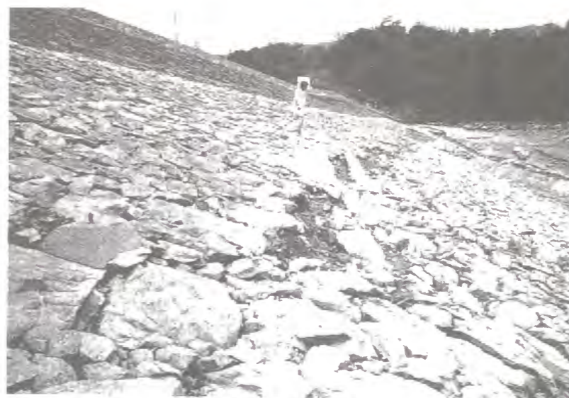
写真-6.4.3 北山第1ダムの上流法面捨石張部
