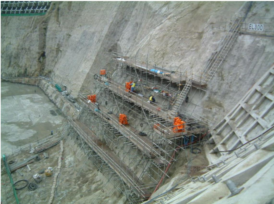
写真-1.1.1 ダム基礎岩盤におけるグラウチング施工状況
