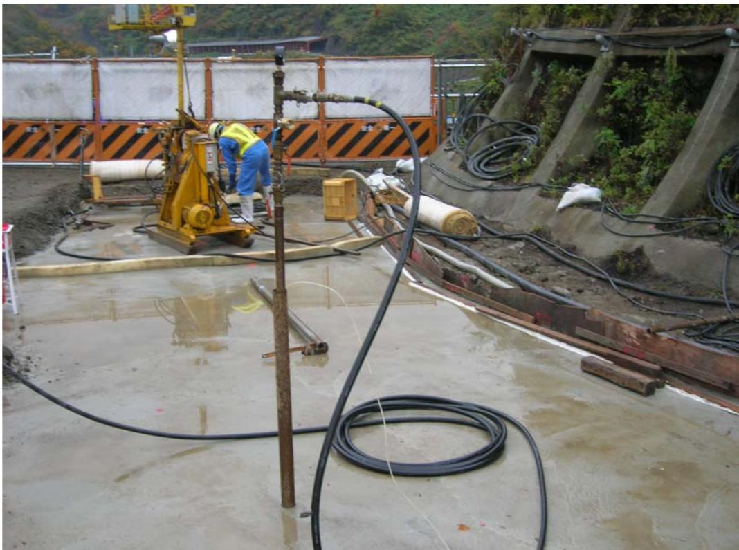
写真-2.1.4 試験ヤードにおけるグラウチング施工状況
