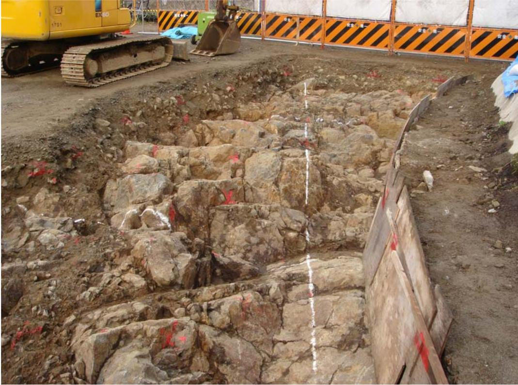
写真-2.1.1 試験ヤードにおける岩盤清掃実施状況
