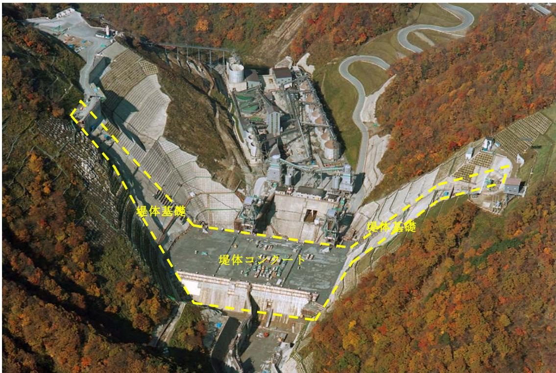
写真-1.3.1 ダム現場における堤体打設施工状況
