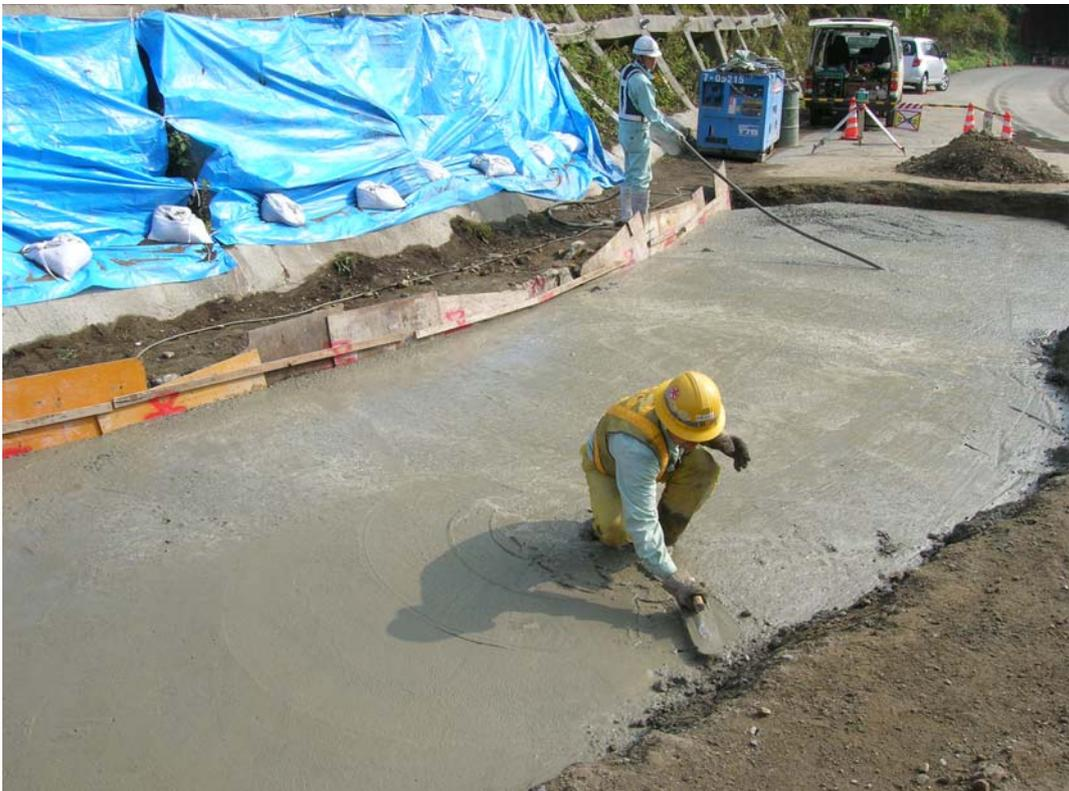
写真-2.1.2 試験ヤードにおけるカバーコンクリート打設状況
