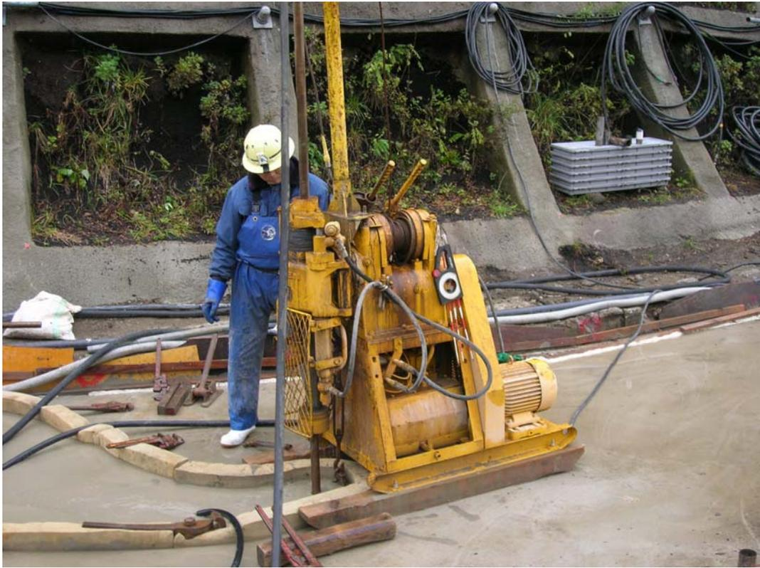
写真-2.1.3 試験ヤードにおけるボーリング施工状況
