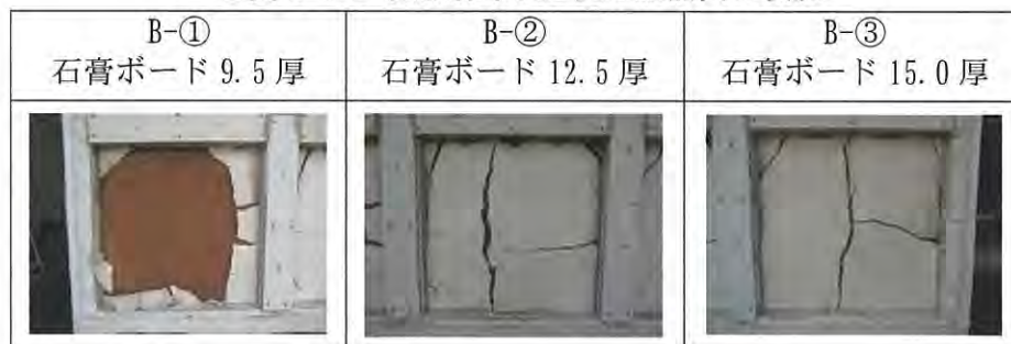
写真 2-1-2 試験体取出し後の加熱面の状況
