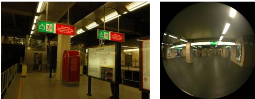
图 3-8 调查对象避難経路 (Beurs、Belgium) 左：ホーム、右：地点 40m 改札階駅舎内部
