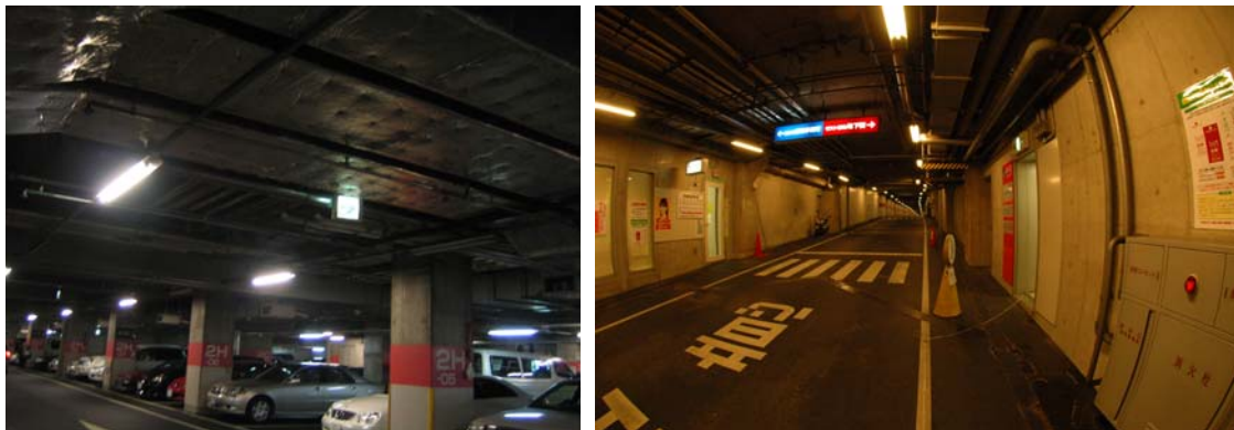
図 8-6 御池地下駐車場の概観（右写真右壁面にある開口部は Room4 への入口）
