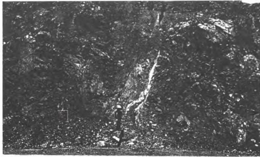
写真6・1 走向N30°W・傾斜80°SWの断層破碎帯
