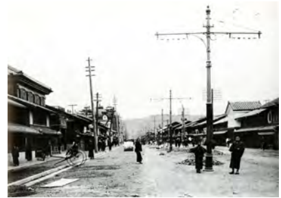
写真7-3 四条通拡幅後の四条烏丸 (同上，p.196.)
