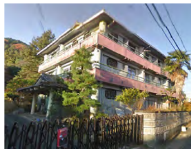
写真6-2 疑問をもたれた建物 1 (「googleマップ」( http://maps.google.co.jp ) の「ストリートビュー」より)
