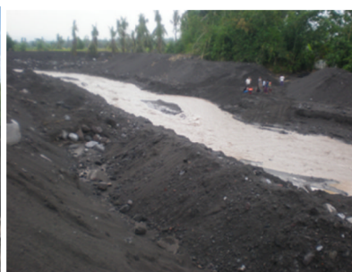
Photo 9(d) Collapse type 4
