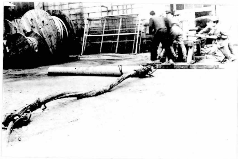
オ86図 キンク試験状況 (その2)
