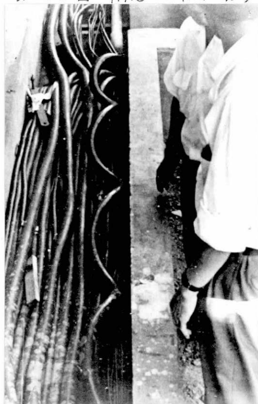
オノフの図 PVCコントロールケーブルのうねり
