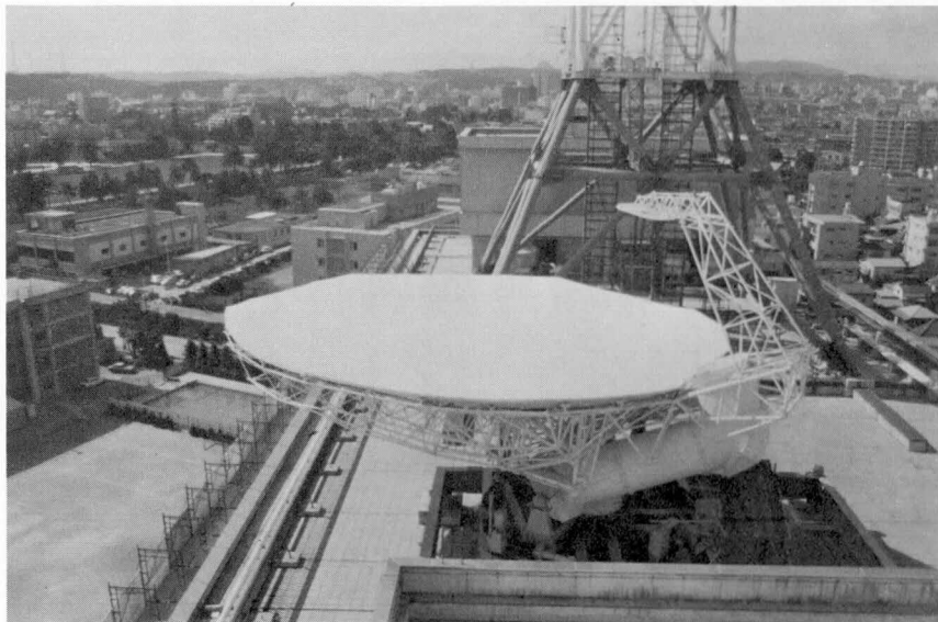
図 4.34 局舎屋上に設置されたオフセットカセグレン地球局アンテナ
