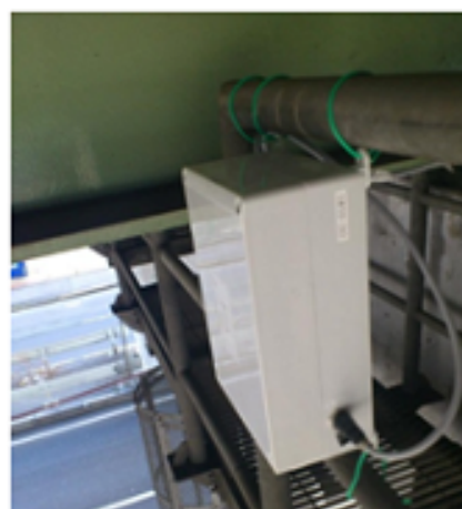
(b) コントロール部設置状況
