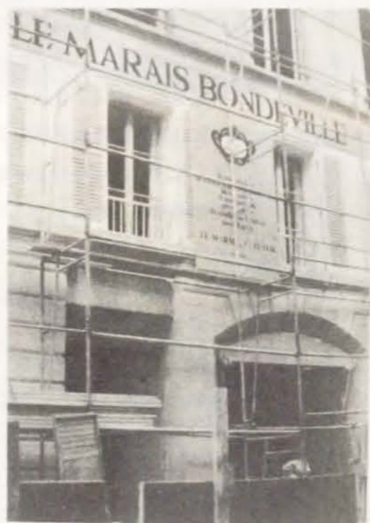
写2-2-1 パリ マレー地区における修復工事
