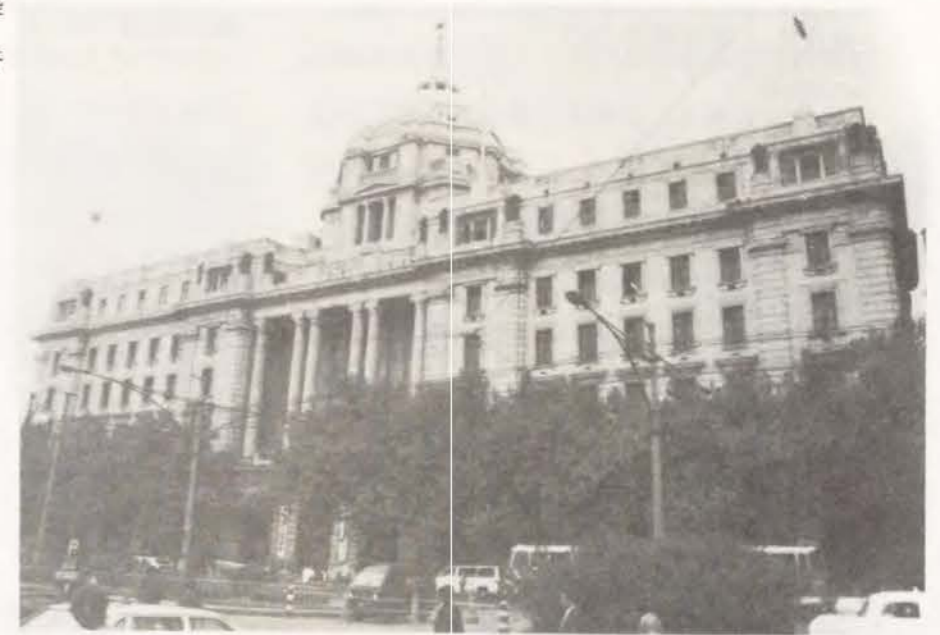
写6-1-1 外灘の洋風建築 —上海市人民政府(旧香港上海銀行1923)
