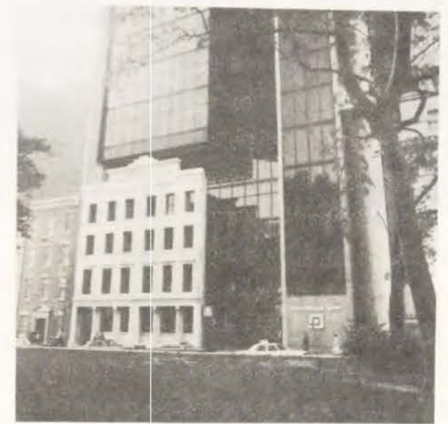
図3-2-1 中京区郵便局のレンガ造外壁保存 写3-2-2 フィラデルフィアの生命保険会社と内部のR.C.構造の外壁の一部保存
