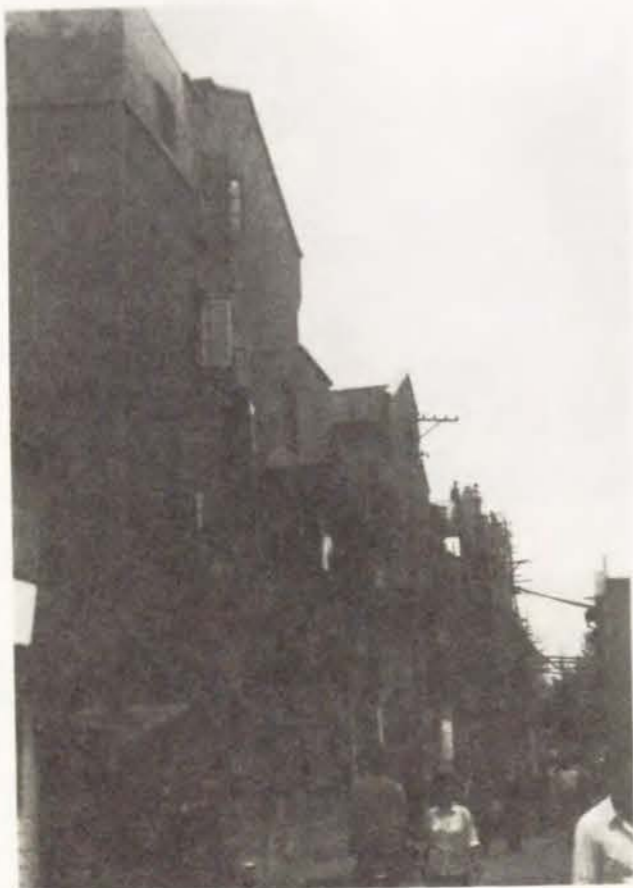
写6-2-1 改造された里弄住宅（蓬莱路303弄）（1989）
