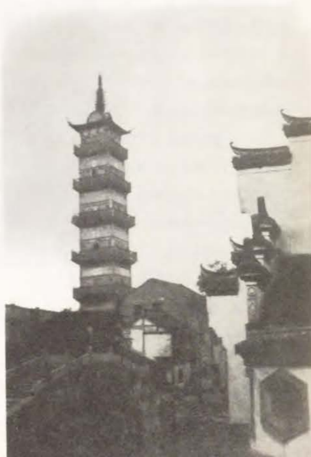
写6-2-2 法華塔と水路橋の景観（1993）
