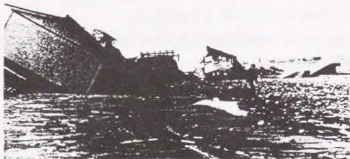
写真-3.1 1970年冬期災害時の横町の被災状況
