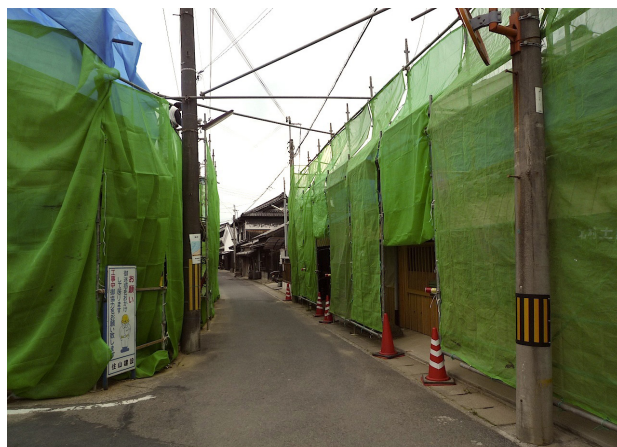
写真6-2 毎年一定量進められる修理・修景工事（北町）
