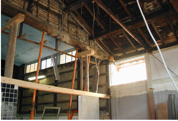
写真6-3 応急修理中の旧銭湯 (撮影：前田和昭)
