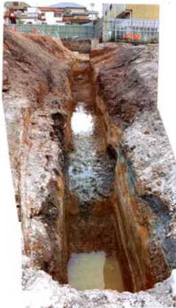
写真2-4. W1トレンチからEトレンチ
