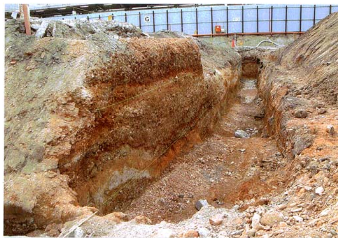
写真2-3. W1トレンチ
