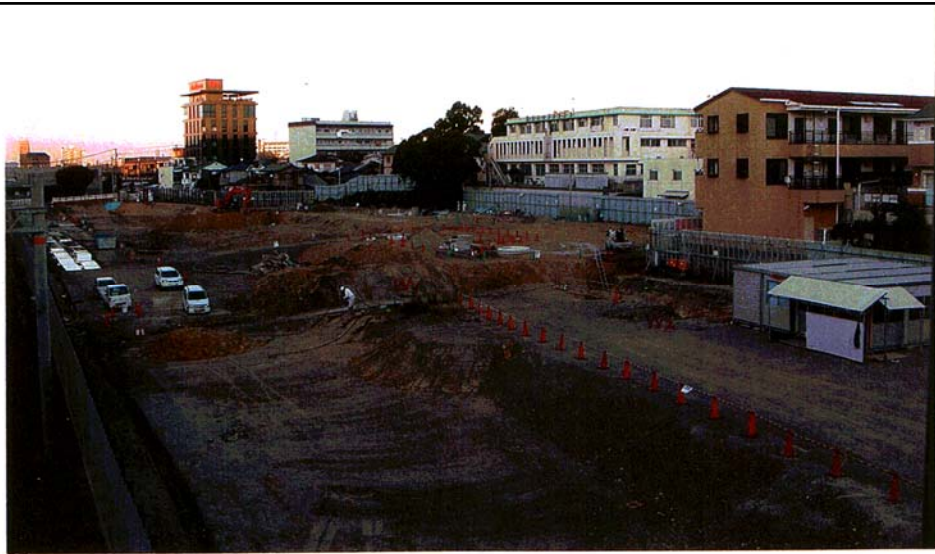
写真2-2. トレンチ調査地全景
