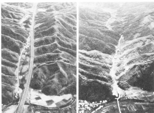
活断層が割れて動いた破砕帯に沿って高速道路がてきる。
