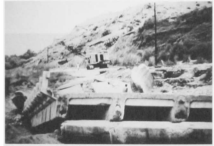
フィリピンの地震。活断層をまたいで架かっていた橋（写真左、地震の二週間前に撮影）が、地震で落ちた（写真右）。
