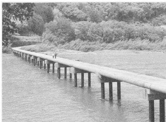
高知県仁淀川の名越歴沈下橋。増水時は橋桁の上を水が流れる。洪水や自然に、人間はさからわないという考え方。
