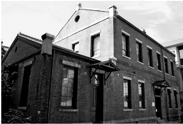
1870年代に建てられたレンガ造りの旧京都織物会社の建物を利用して、1965年に開室した東南アジア研究所図書室
