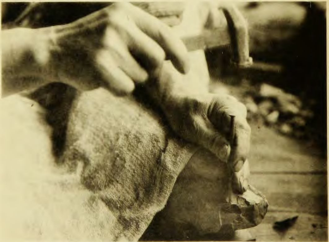
(2) 原石の石質検査の爲め破碎す
