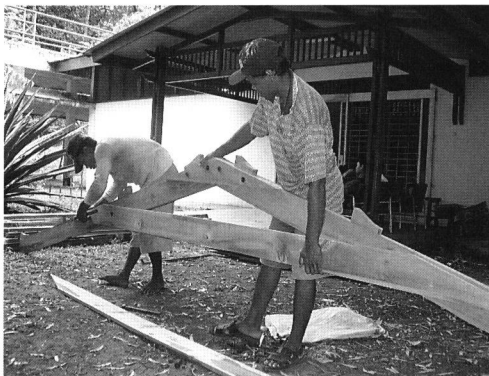
b) 骨組み架構の製造と建ち上げ
