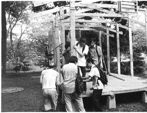
c) 骨組み架構建ち上げ作業の完成
