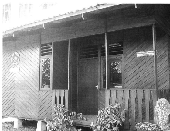
図8：プレファブシステムで造られた耐震モデル住宅
