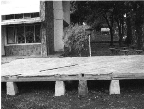
a) コンクリート製独立基礎と床構面の施工
