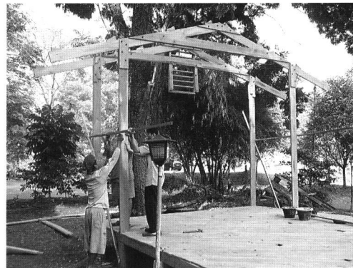
b) 骨組み架構の製造と建ち上げ
