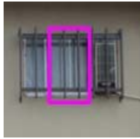
図-17 格子間隔の広い格子窓での過小抽出例
