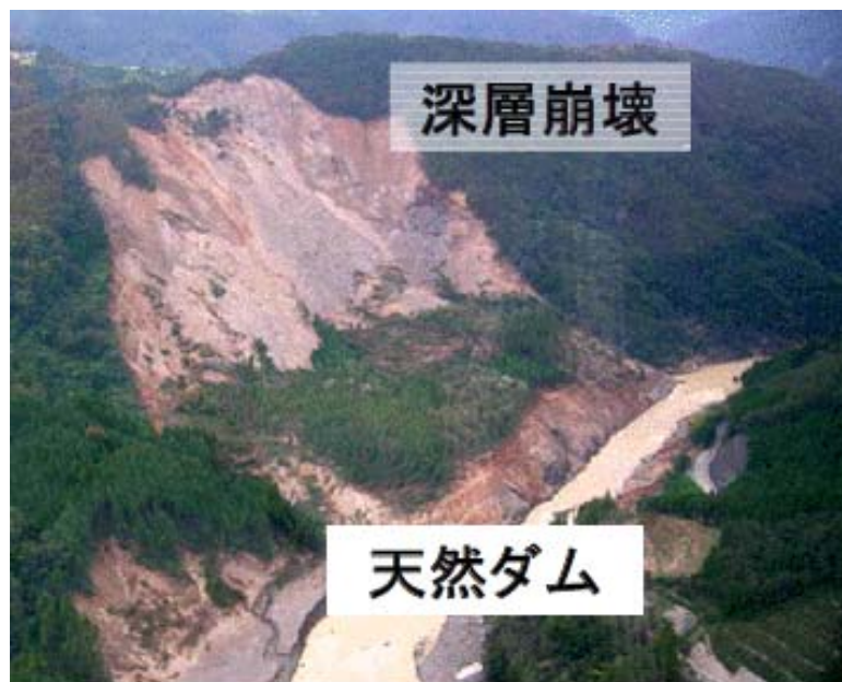
写真 1-2 天然ダムの形成事例（宮崎県耳川（2005年9月））
