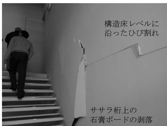
図 4-11 階段室の石膏ボードの直貼り仕上げの損傷状況（1～2階）
