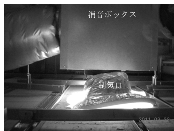
図 4-13 天井内吊り設備の残留変形の状況（3 階）
