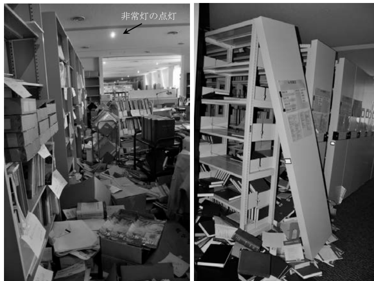
図 4-14 図書館内の被災状況（2 階）
