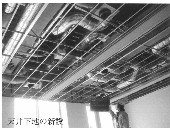
図 4-19 3階・会議室の天井，建築設備の復旧状況
