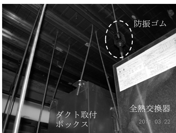
図 4-13 天井内吊り設備の残留変形の状況（3 階）
