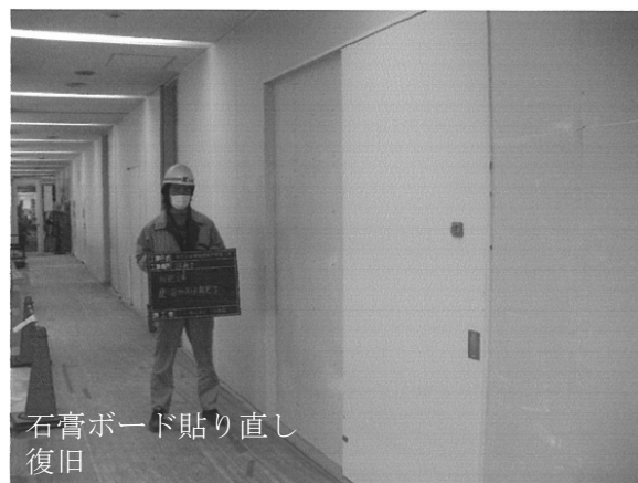
図 4-17 2 階・廊下部分の間仕切り壁の復旧状況
