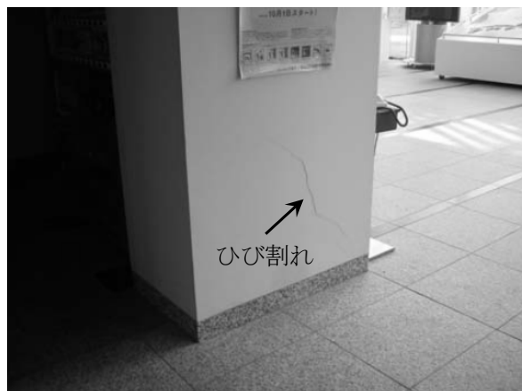
図 4-7 1 階の仕上げ部材の損傷状況
