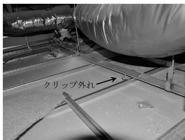
図 4-10 3階の天井の下地材の損傷状況
