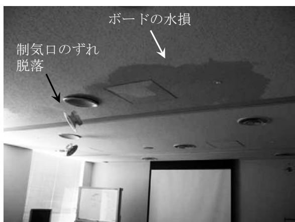
図 4-9 3 階の天井の損傷状況および漏水が発生したアトリウムの屋上
