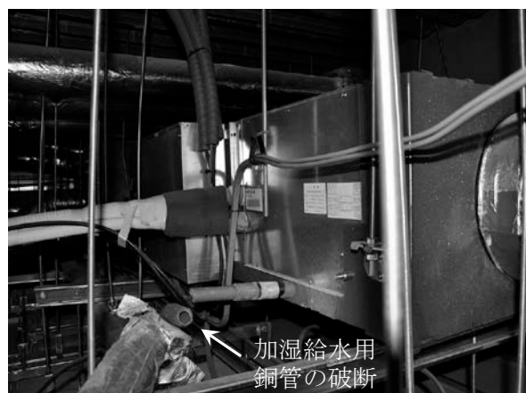
図 4-12 全熱交換器周辺のダクト破損状況（3 階）
