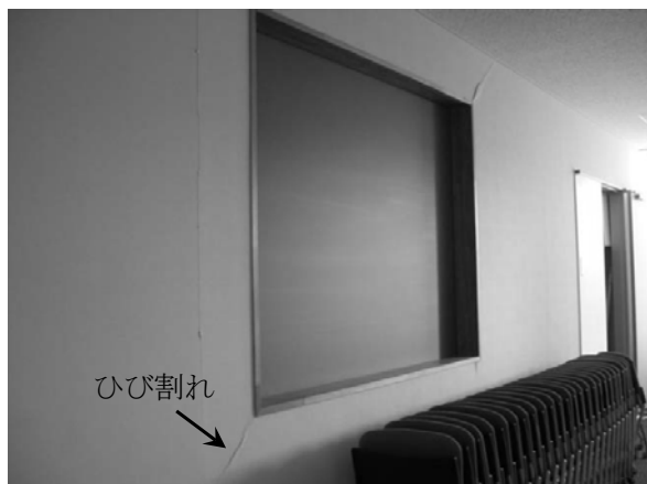
図 4-7 1 階の仕上げ部材の損傷状況
