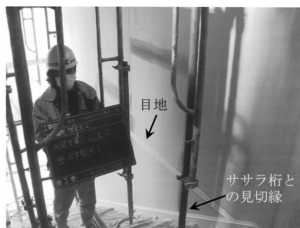
図 4-18 1～3 階・階段室の壁の復旧状況
