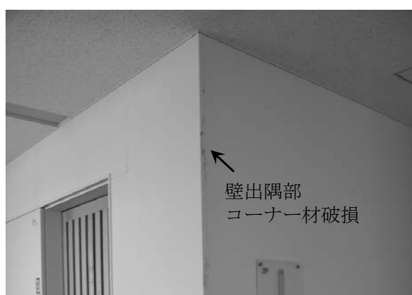
図 4-8 2 階の非構造壁のひび割れ、損傷状況
