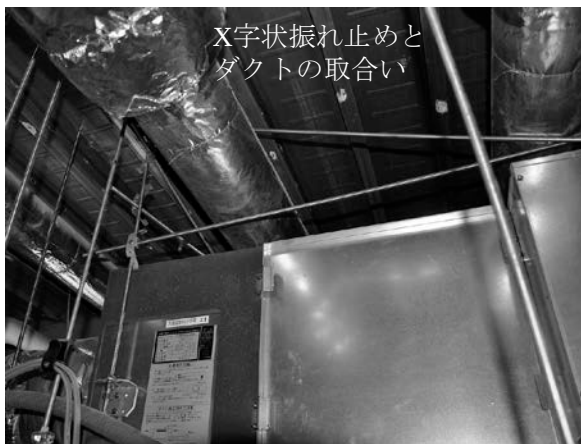
図 4-20 3階 天井内の全熱交換器の復旧状況
