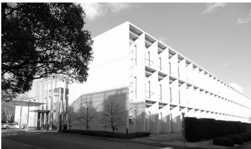
図 4-1 対象建物の全景
