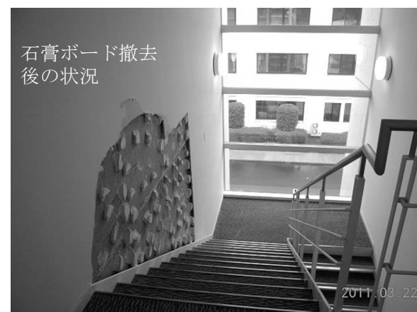
図 4-11 階段室の石膏ボードの直貼り仕上げの損傷状況（1～2階）
