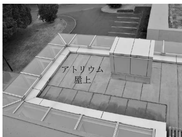
図 4-9 3 階の天井の損傷状況および漏水が発生したアトリウムの屋上
