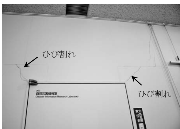
図 4-8 2 階の非構造壁のひび割れ、損傷状況
