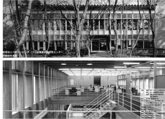
図8 平面的混構造の 6) (手前が木造で奥が鉄筋コンクリート造)
