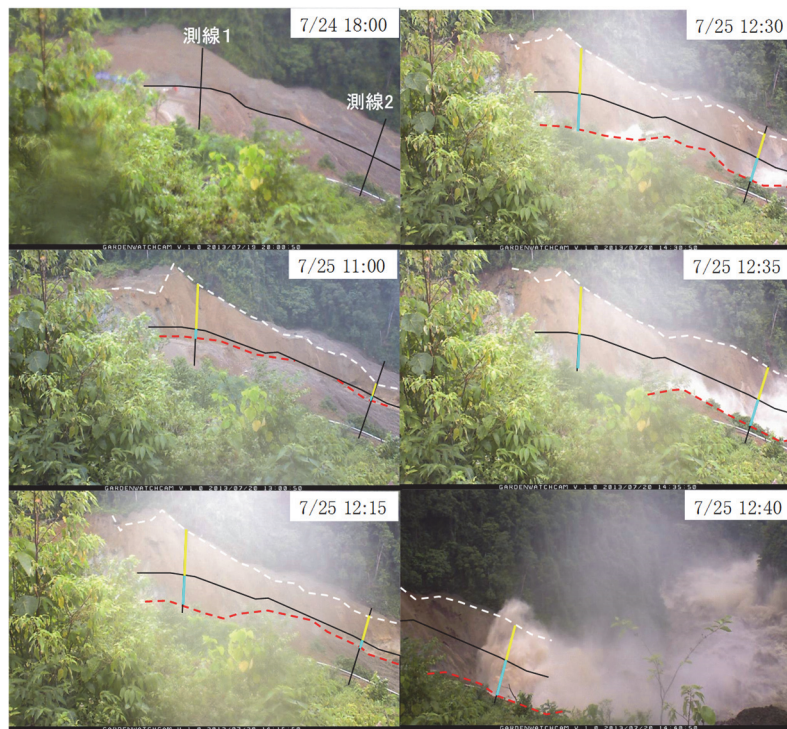
図－2.28 天端下部における水みち拡幅の状況
