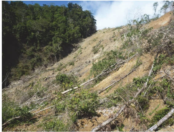
図－2.16 天然ダム下流斜面の状況
