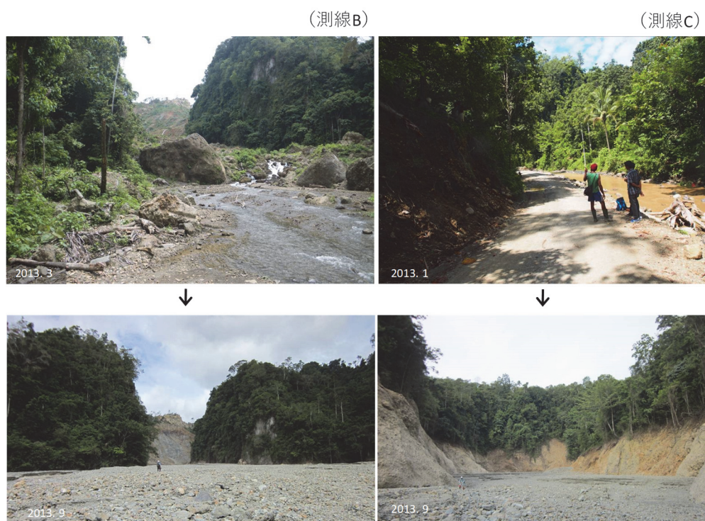
図－2.11 決壊前後の河道内の状況
