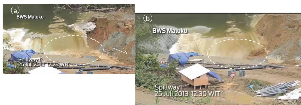
図-2.31 排水路呑み口の状況（ビデオカメラA）
