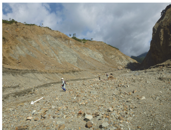
図－2.10 天然ダム堤体付近の決壊後の状況（測線 A）
