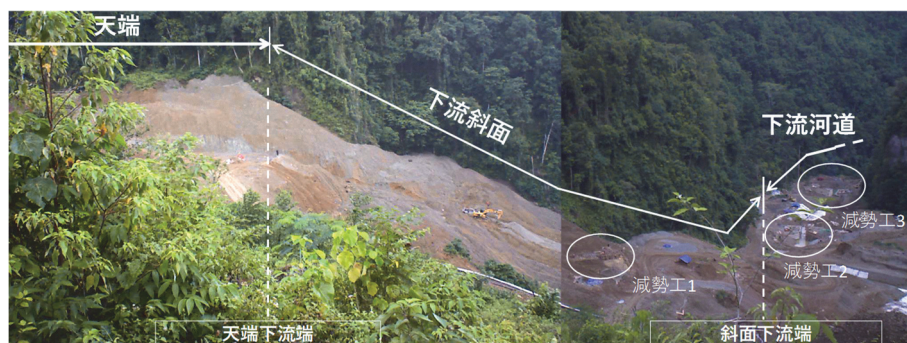
図－2.25 決壊前の下流斜面の状況（インターバルカメラ設置地点より）
