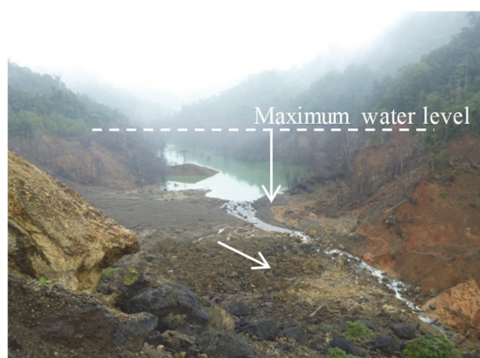
図－2.9 決壊後の湛水池の状況
