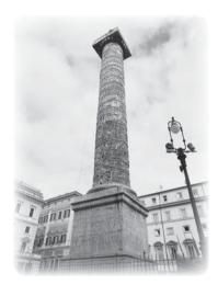
現在見ることのできるドーリア式円柱そのものの高さは30メートルであるが、建てられたとき、柱は高さ10メートルの基壇の上に置かれていた。さらにその下に厚さ3メートルの基礎があった。この円柱を1589年に復元したローマ教皇シクストゥス5世は、その当時の地面の高さで復元したので、基礎だけでなく、基壇の一番下の部分、高さにして3.8メートル分も埋めたままにした。従って、現在見ることの出来る基壇の部分は、基壇全体の3分の2ほどである。基壇の表面には、この柱の描く情景や修復のことなどの説明がラテン語で刻ま
