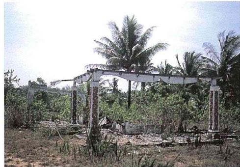
写真8 西カリマンタン州サンバースのマドゥーラ人の家の焼跡
