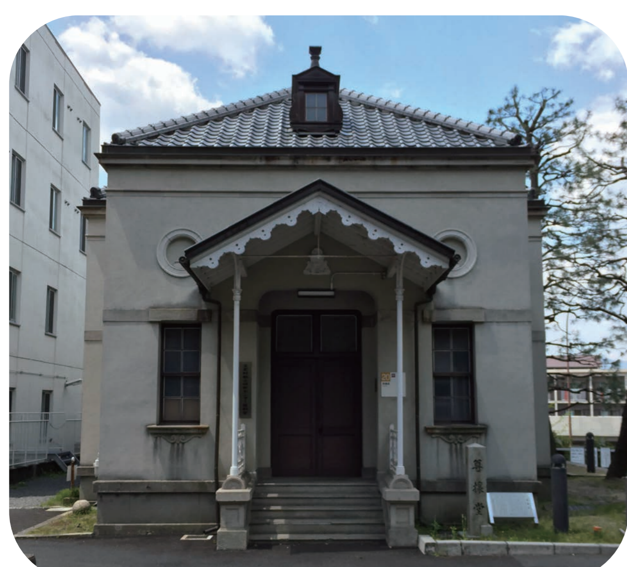
★資料展示室・尊攘堂（国登録文化財） ※現在改修工事中です
