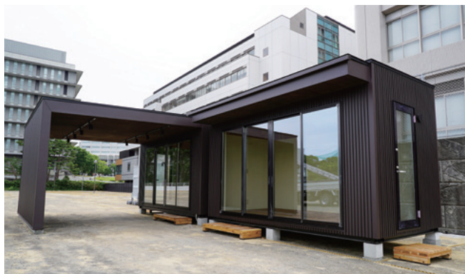
CLT ユニットによる仮設検査場
