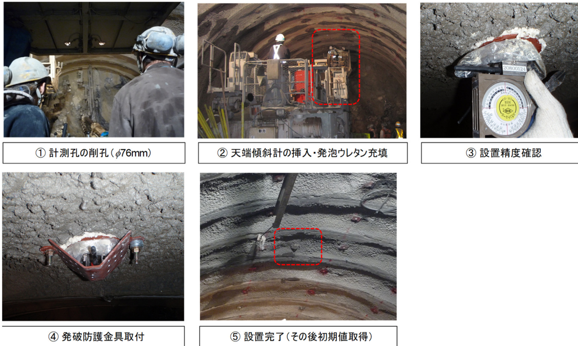
図 4-8 天端傾斜計の設置状況図
