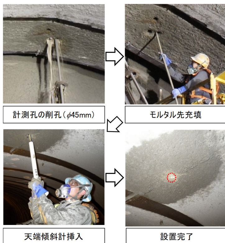
図 4-16 改良型天端傾斜計の設置手順
