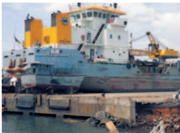
写真1 Galle港における被害（浚渫船が岸壁に打ち上げられ、岸壁も吸い出し被害を受けている）
