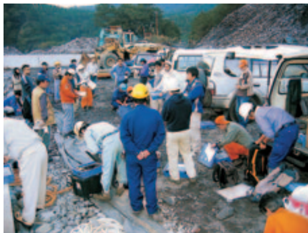
爆破実施直前の打ち合わせ
