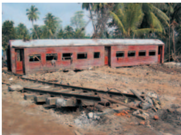
写真2 列車の被害状況（線路は海岸線から約200m離れており、地盤高は海岸線の道路より低い）
