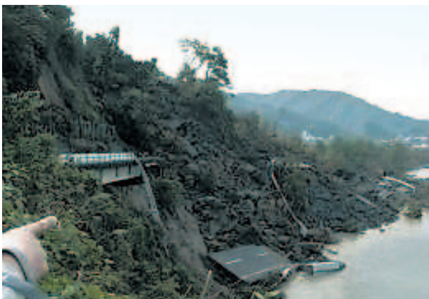
写真-2 県道589号の崖崩れ
