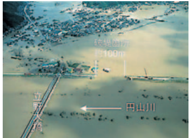
写真1 円山川立野地先での破堤氾濫 (国土交通省 近畿地方整備局 提供)
