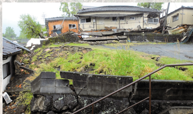
図4-2 益城町中心部(文化センター周辺)に発生した小規模地すべり。地すべりの影響を受けて住宅が圧壊している。この地区の斜面のほとんどは、人工的に地形が変えられており、明治期からの都市形成(土地利用)の過程で形成された古い盛土(生活盛土)が多い。
