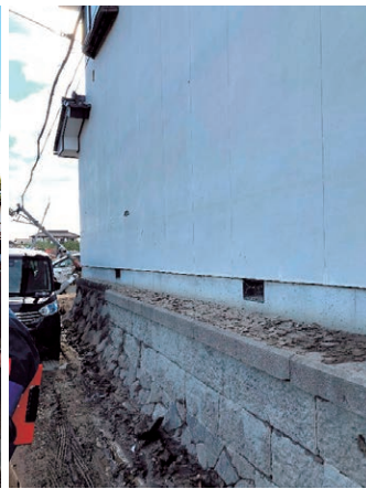
図5 石積みによるかさ上げ
