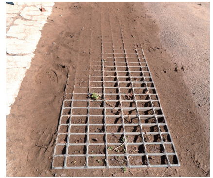
長野市穂保地区の側溝堆積した土砂で閉塞してしまい氾濫水が流入できず排水不能に
