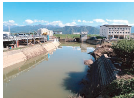
千曲川合流直前の浅川と浅川第二排水機場(右) 千曲川の水位上昇のため水門の閉鎖に続いてポンプの運転も停止
