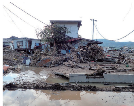
図2 流出した上部構造
