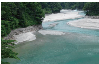
図1 黒部川流域の出し平ダム貯水池における流れと土砂の堆積状況
