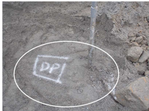
写真-8 二重管ダブルパッカ工法改良体
