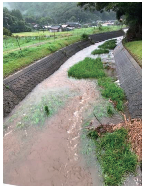
小川の中の草。 流される砂が草の中に堆積し出水毎に高くなる
