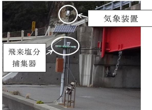
Fig. 3.6.4 気象装置の設置位置
